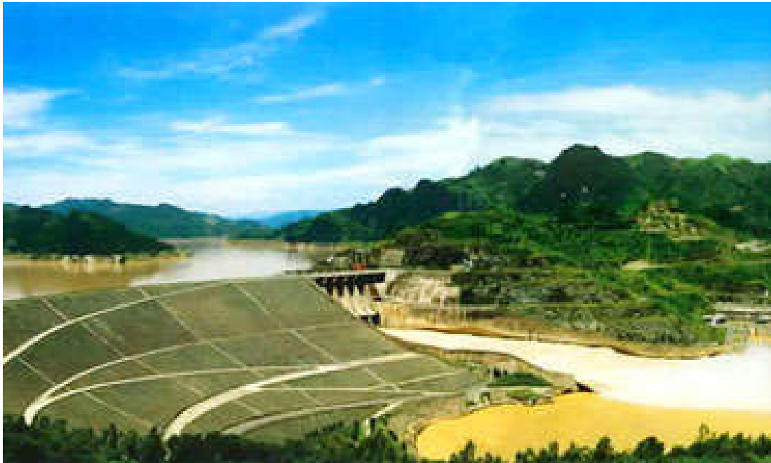
Hình 4. Hình ảnh đập và cửa xả lũ
