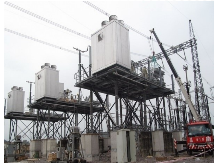
Hình 1: Hệ thống tụ bù dọc
